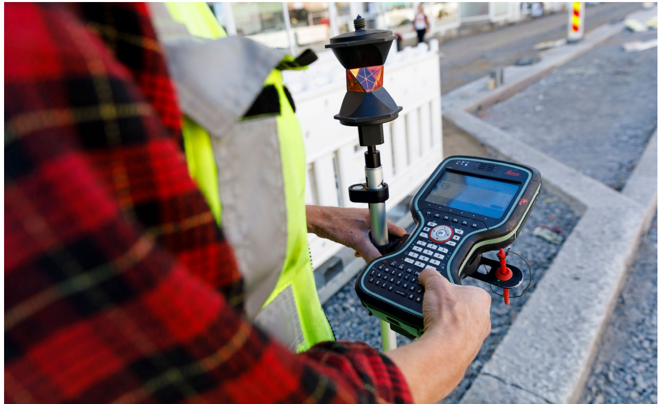
Tarkastusmittauksia työmaalla. Kuva: Raitiotieallianssi / Pasi Tiitola.
