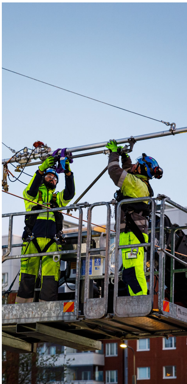
Ajojohtimien asennusta Hervannassa keväällä 2019. Kuva: Raitiotieallianssi / Pasi Tiitola.
