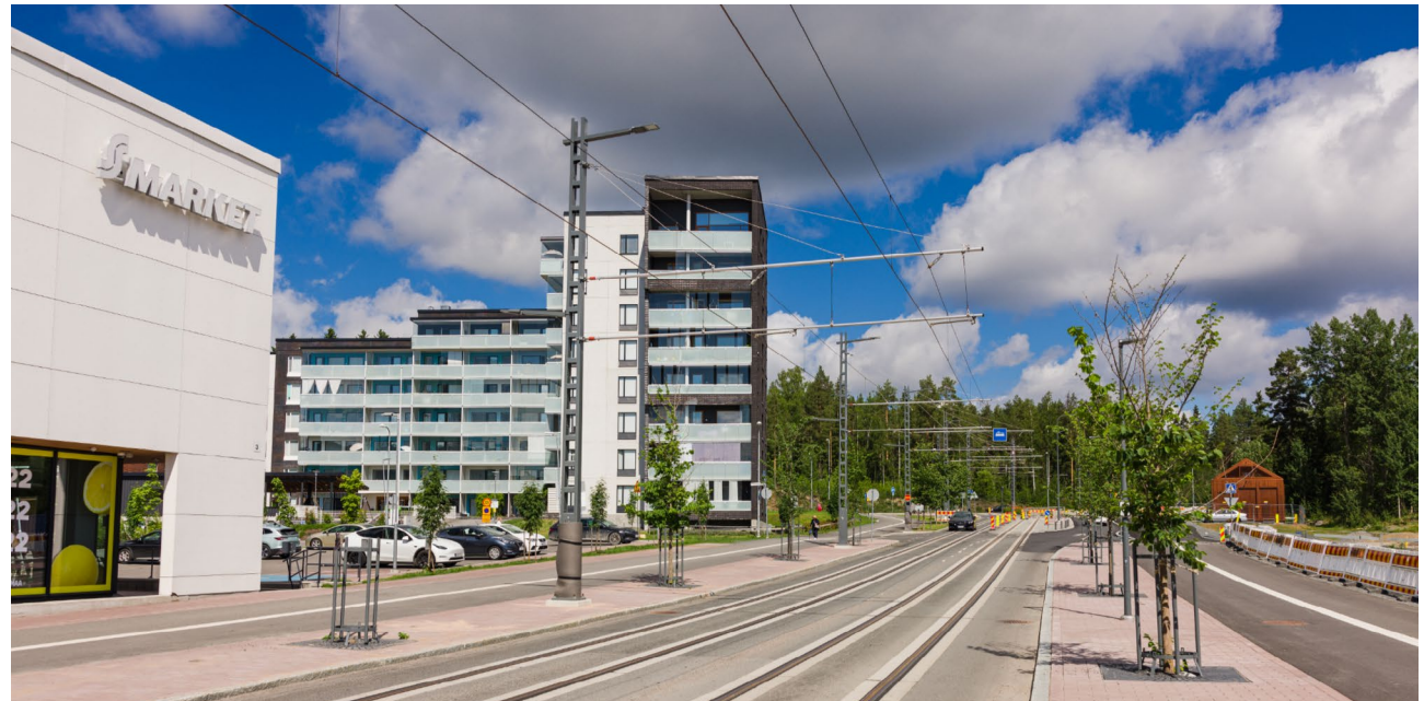
Raitiotie Kehyskadulla Niemenrannassa. Raitiotieliikenne Lentävänniemeeseen on tavoitteena aloittaa tammikuussa 2025. Kuva: Raitiotieallianssi / Pasi Tiitola.
